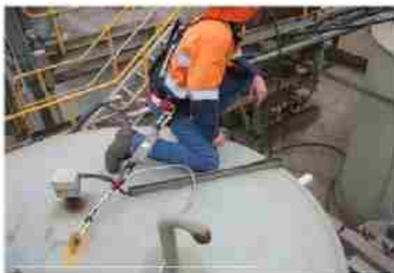
شکل ۳-۵۴ محدودکننده با اتصال یک رشته
