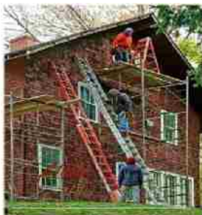
شکل ۲۸- استقرار نردبان روی جابجاء کار ممتوع
