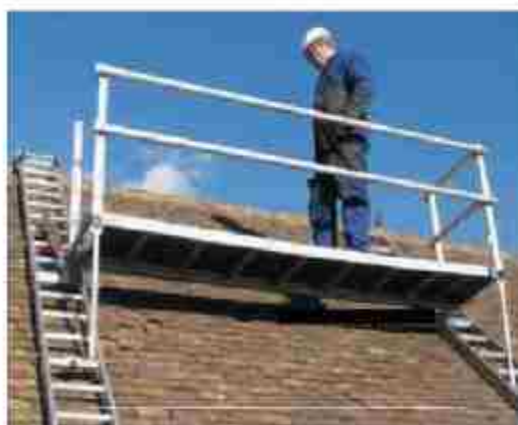
شکل ۳۰- جابجاء کار روی سطوح شیبدار
