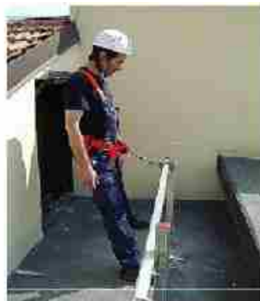
شکل ۴-۵۴ محدودکننده با اتصال یک ریل مخصوص
